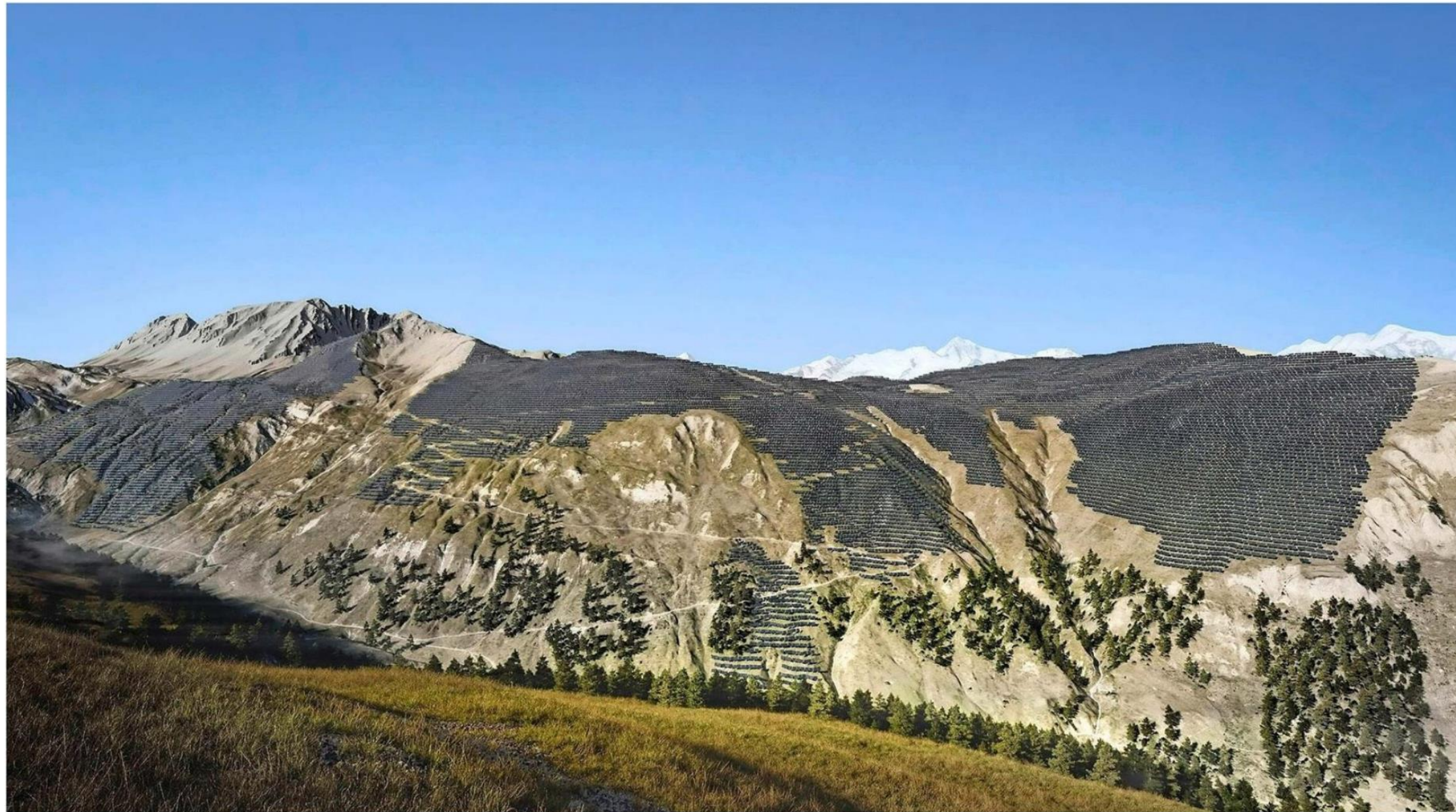
Le parc solaire alpin projeté à Grengiols dans la vallée de Binn comprendrait 910 000 modules photovoltaïques. SWISSTOPO/NIGHTNURSE IMAGES
